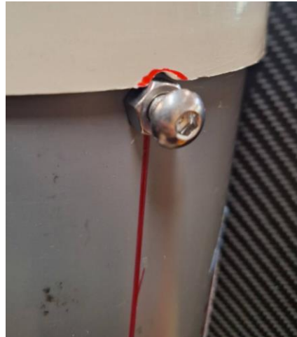
底座使用3支膨脹螺絲固定端點
